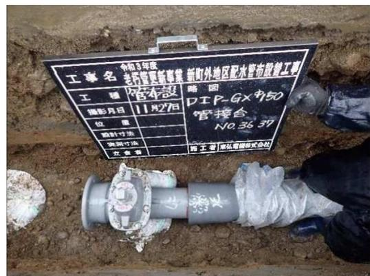
耐震継手ダクタイトイル铸铁管
