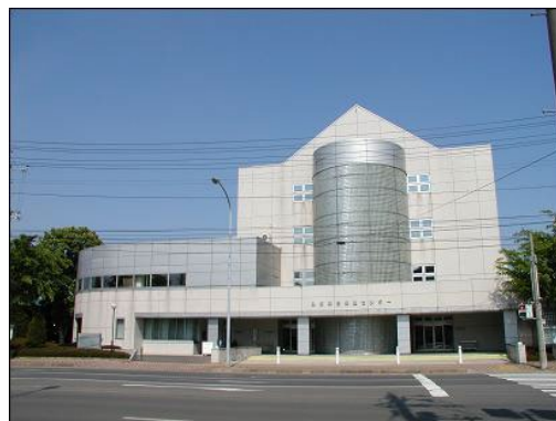
弘前保健センター
