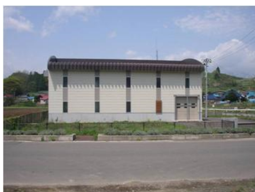
相馬揚水機場
