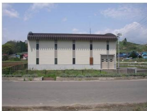
相馬揚水機場
