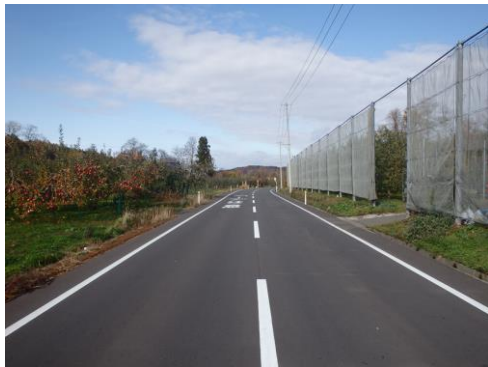
改修後の農道
