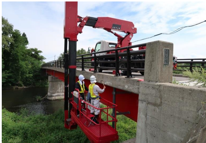
橋梁の点検の様子
