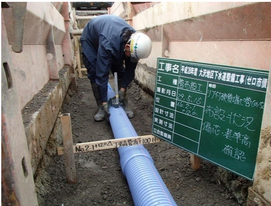
下水道整備工事の様子
