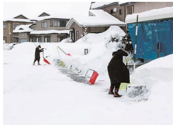
消流雪溝投雪状況
