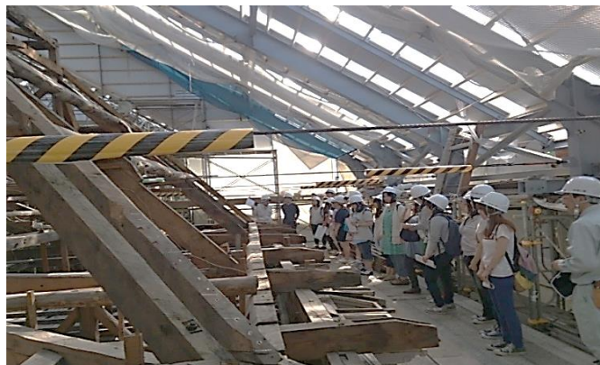
旧弘前偕行社保存修理の見学
