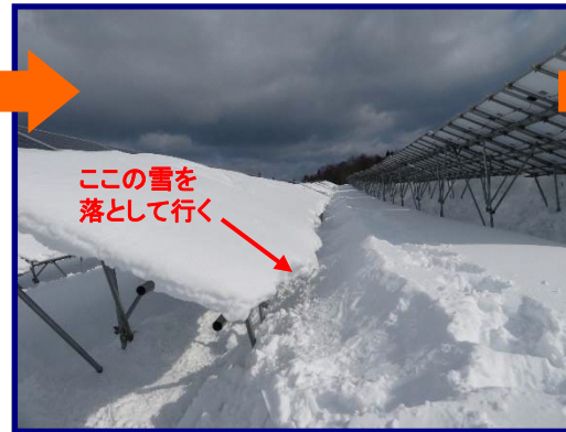
②まず最初に、除雪機が使用できないパネルにかかった雪を、パネル間の通路へ落としていきます。
