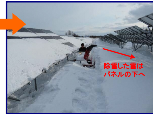
③除雪機を使用して、パネル間の通路を除雪して行きます。 雪がパネルの下へ溜まるように、除雪します。
