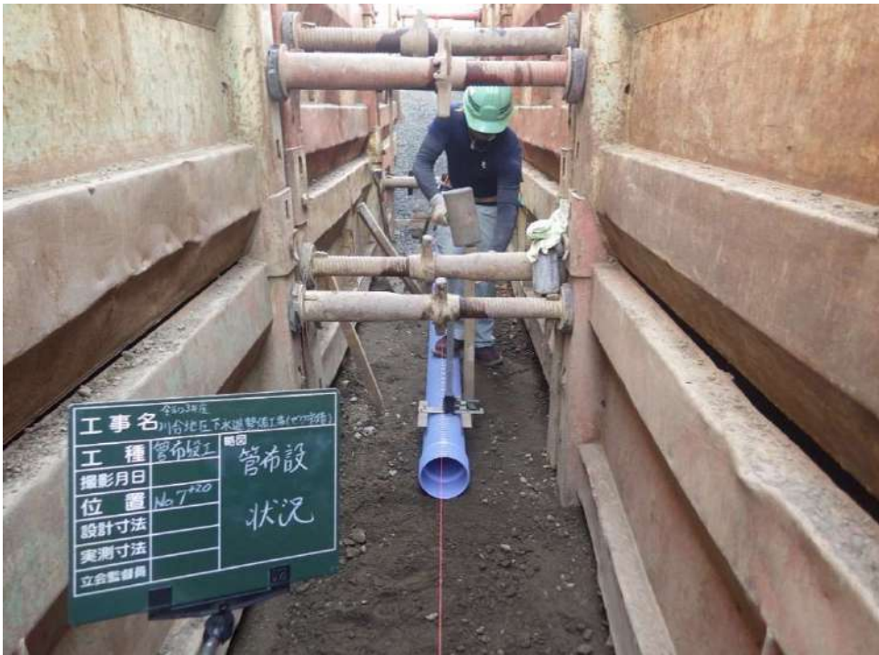
下水道工事の様子
