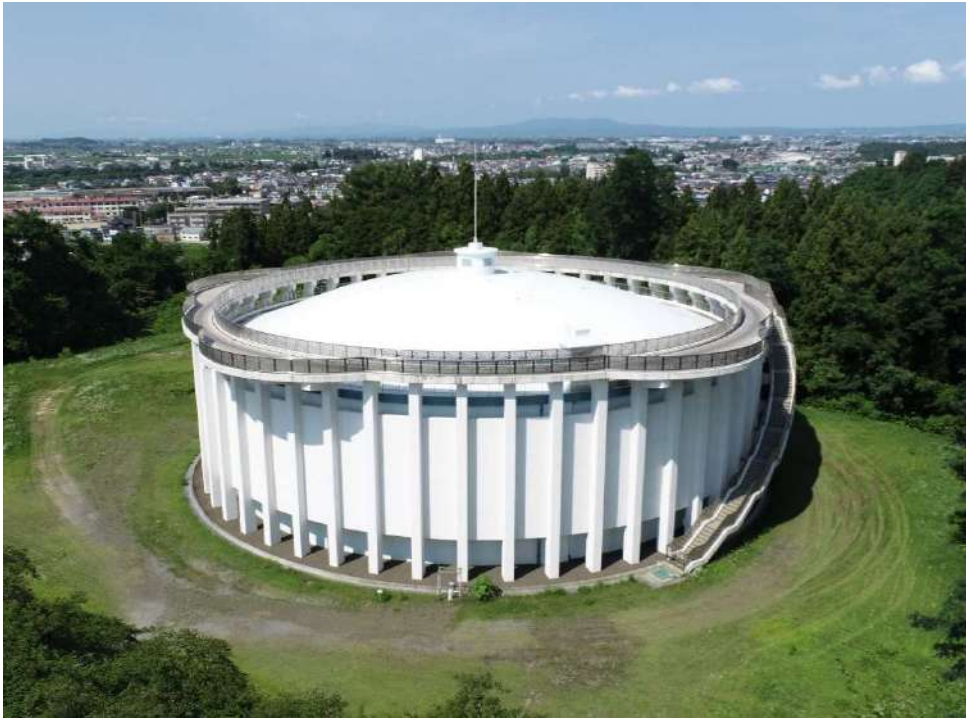
常盤坂配水池
