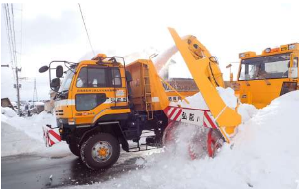
運搬排雪作業の様子
