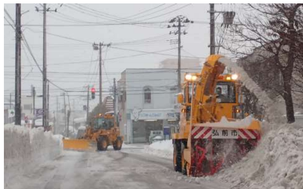
拡幅・路面整正作業の様子
