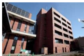
市庁舎に設置した太陽光パネル
