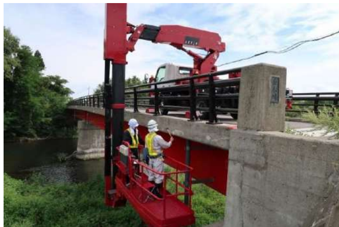
橋梁の点検の様子
