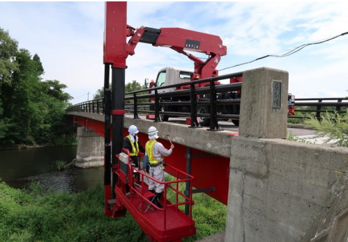
橋梁の点検の様子
