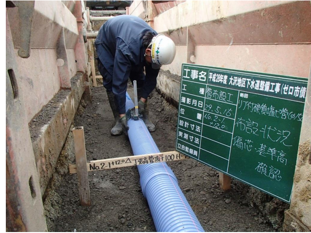
下水道整備工事の様子
