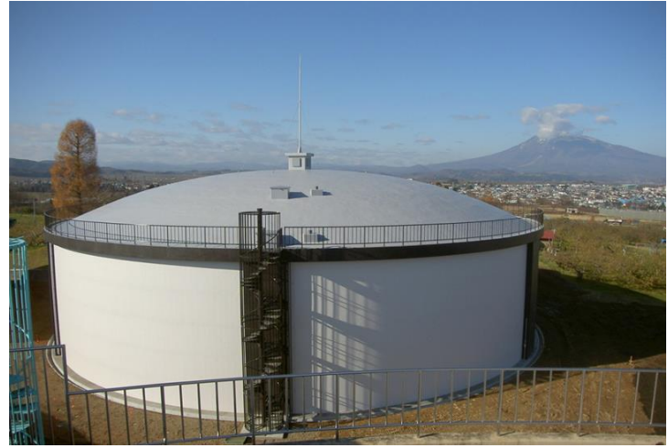
原ケ平配水池
