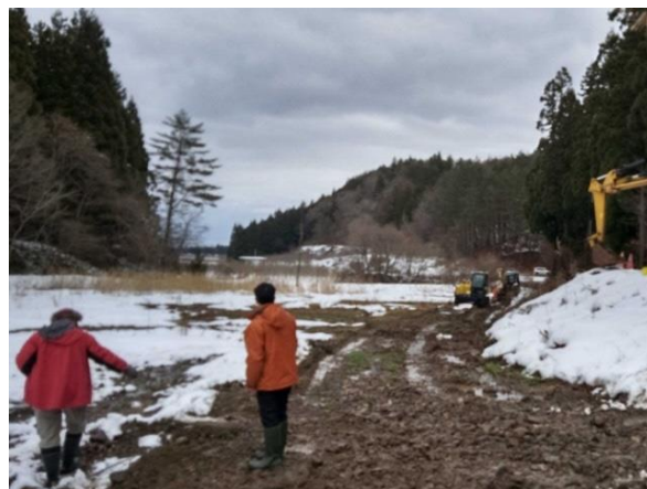
12月12日市復旧工事始まる
