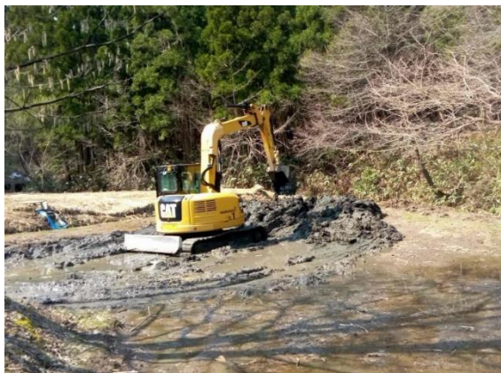
ウルメ池泥上げ修正作業
