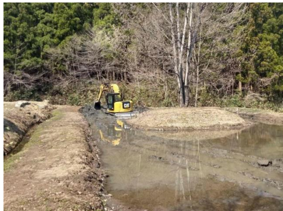
ウルメ池泥上げ修正作業
