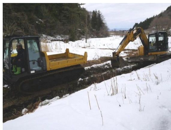
市復旧工事大畑沢土砂上げ
