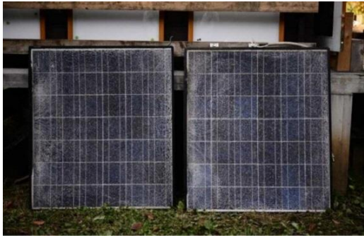
10月20日取り外した太陽光発電パネル
