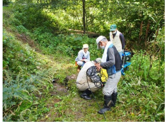
高圧ジェット赤沢取水管閉塞除去
