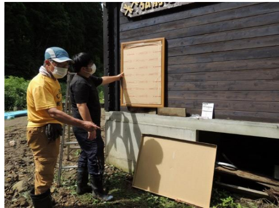
4基目の掲示板設置
