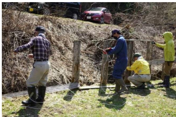
大畑沢防護柵補修
