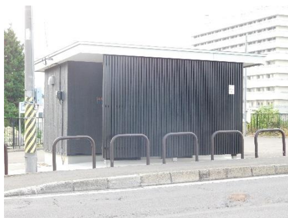
南塘町バスプール公衆トイレ
