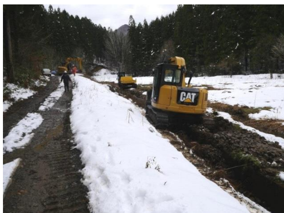
市復旧工事大畑沢土砂上げ
