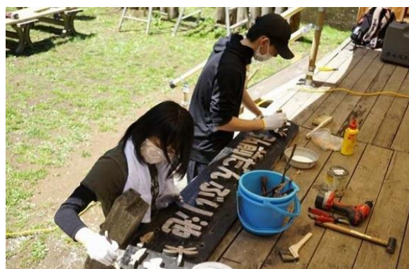
だんぶり池看板塗装補修
