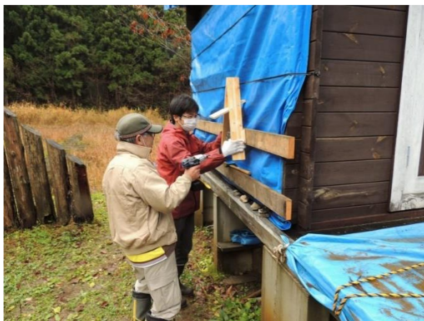
11月27日定点カメラ雪除け設置
