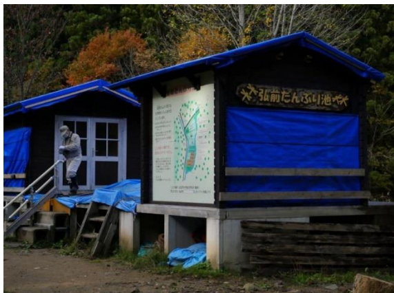
小屋掲示板ブルーシート掛け
