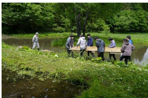
ウルメ池木道基礎板運搬
