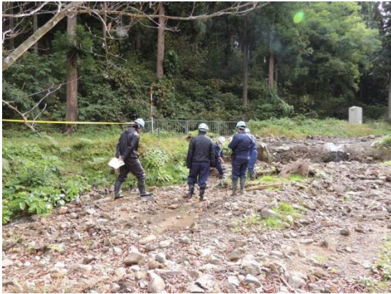
県発注復旧工事業者現地打合せ
