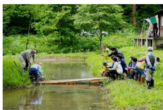
ウルメ池木道基礎板設置
