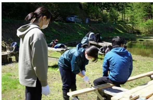
ウルメ池流入口U字溝歩板製作
