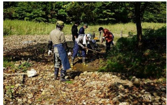
大畑沢水路人力修復
