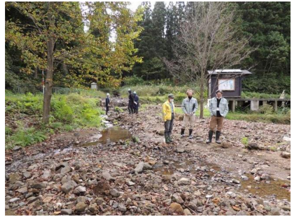
県発注復旧工事業者現地打合せ
