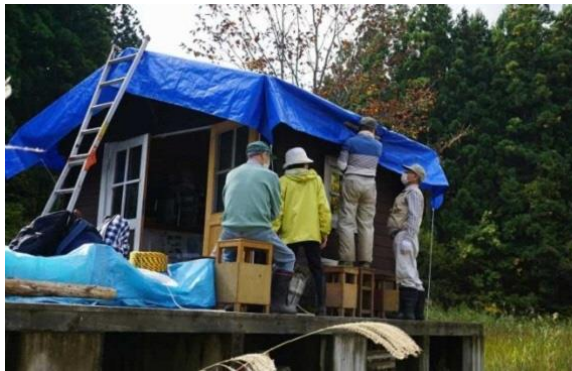
観察小屋屋根ブルーシート掛け
