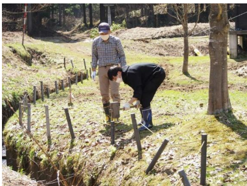
大畑沢防護柵補修
