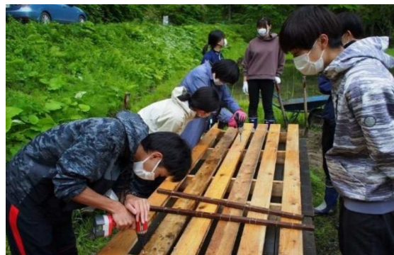
ウルメ池木道基礎板製作
