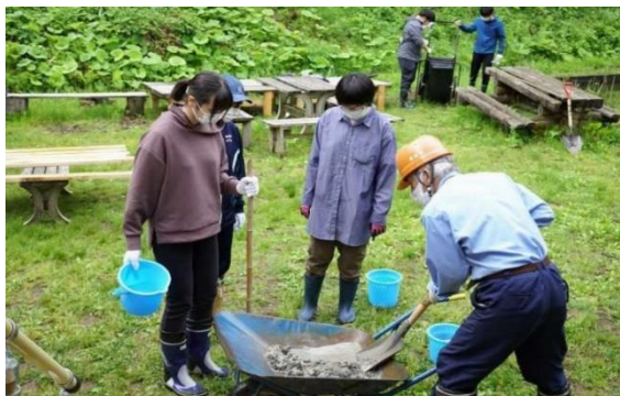
デッキ階段モルタルづくり
