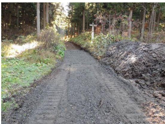
林道復旧状況
