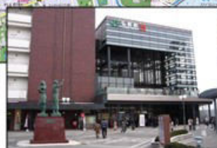
■弘前駅東西自由通路
