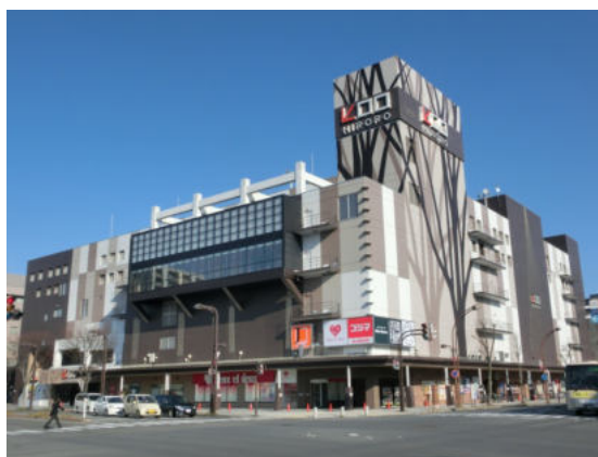
○弘前駅前地区再開発ビル再生事業(ヒロロ)
