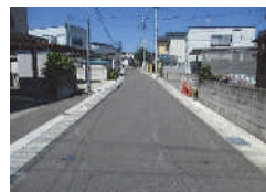
改修後の生活道路
