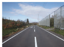
改修後の農道
