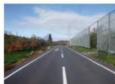
改修後の農道
