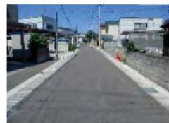
改修後の生活道路
