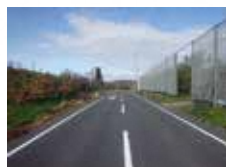
改修後の農道
