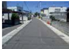
改修後の生活道路
