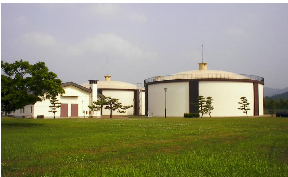
富士見台配水場
