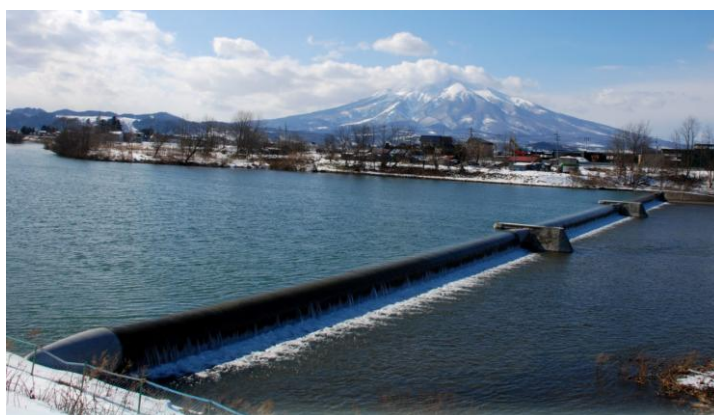
岩木川取水堰（ラバーダム）
