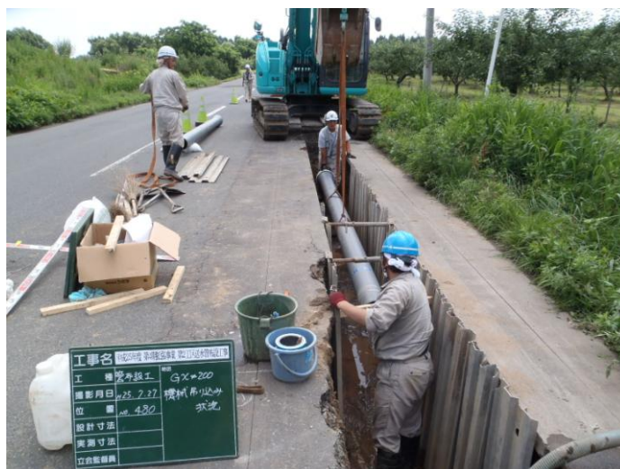
管路布設工事の様子
