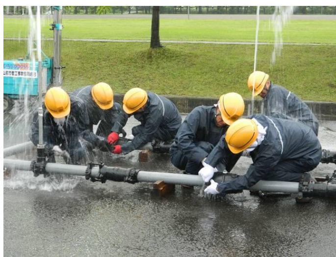
市総合防災訓練での漏水訓練の様子
