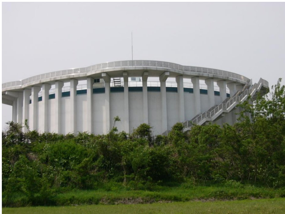
常盤坂配水池
