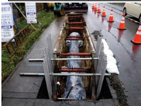
【上水管路耐震管布設状況】
