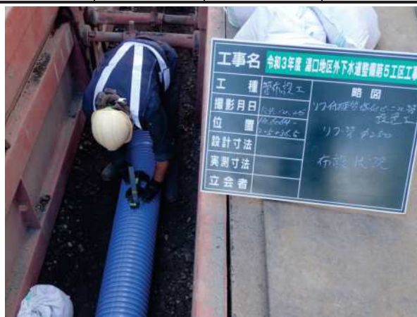
【下水管路耐震管布設状況】
