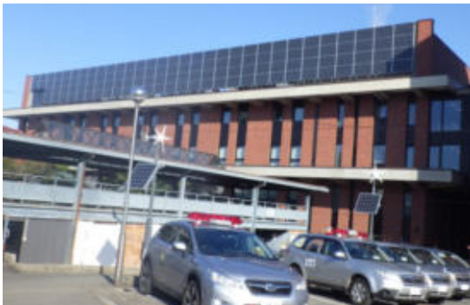
市役所屋上に設置してある太陽光パネル
