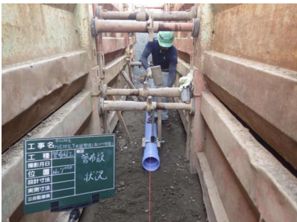
下水道工事の様子
