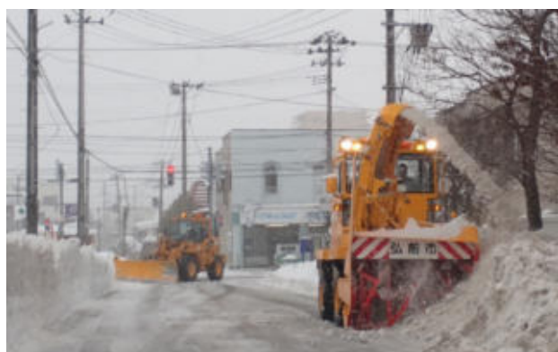
拡幅・路面整正作業の様子
