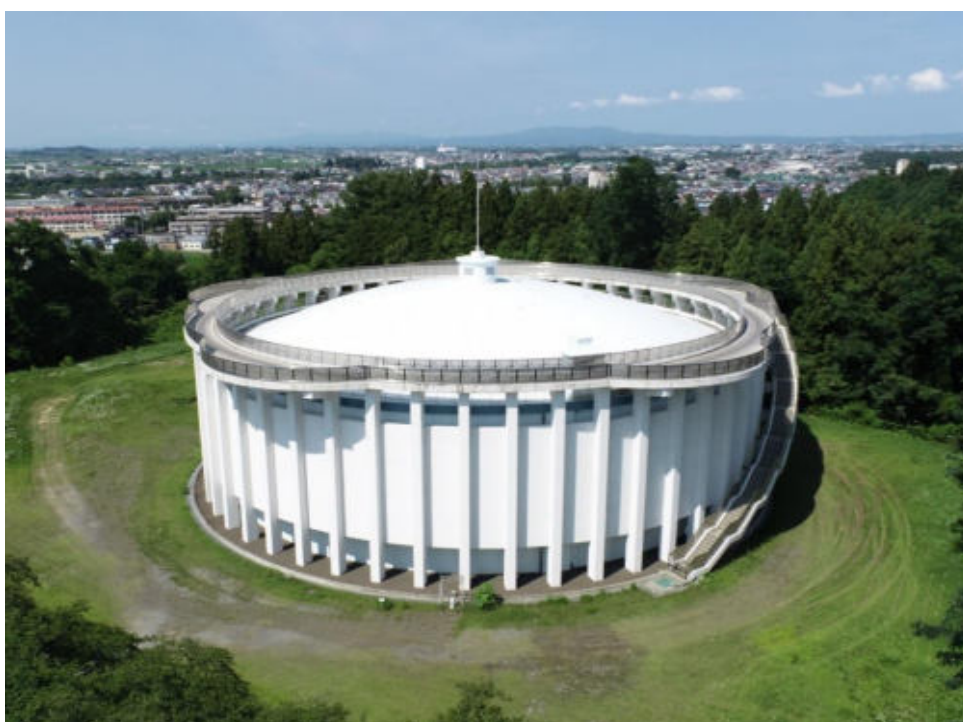
常盤坂配水池
