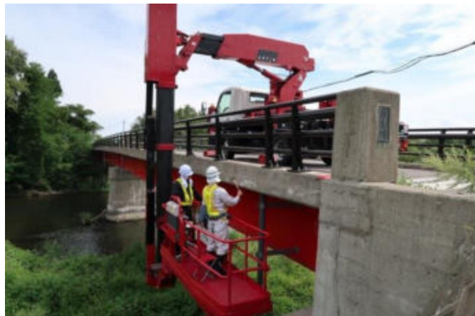
橋梁の点検の様子
