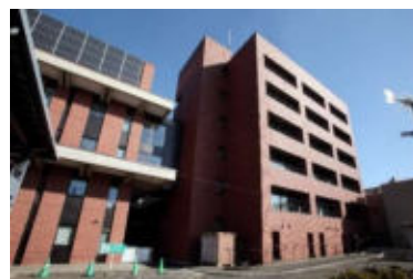
市庁舎に設置した太陽光パネル
