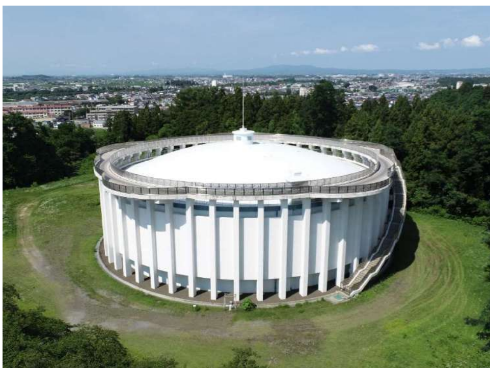
常盤坂配水池
