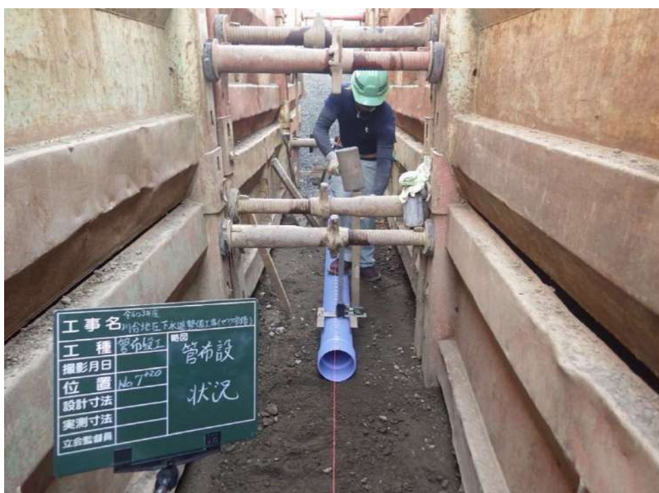
下水道工事の様子
