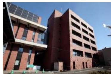
市庁舎に設置した太陽光パネル
