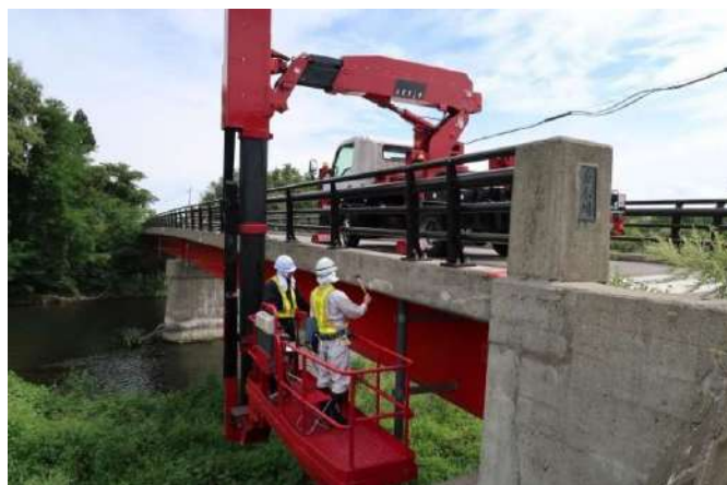
橋梁の点検の様子
