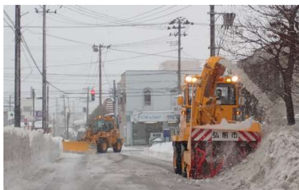
拡幅・路面整正作業の様子
