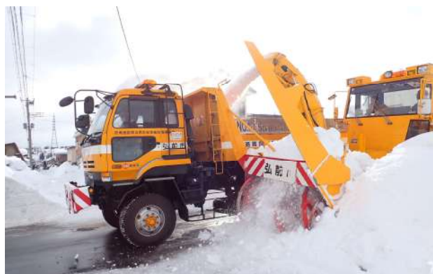
運搬排雪作業の様子
