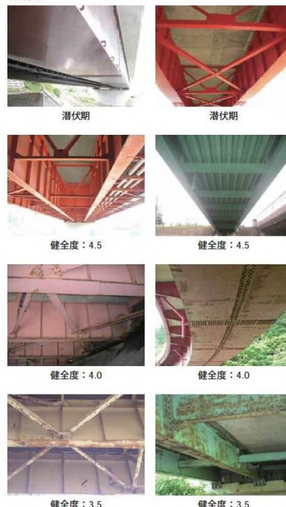
図 5.4 健全度評価基準の例(点検ハンドブック)
