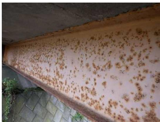
写真 3.1 塗装の損傷状況
