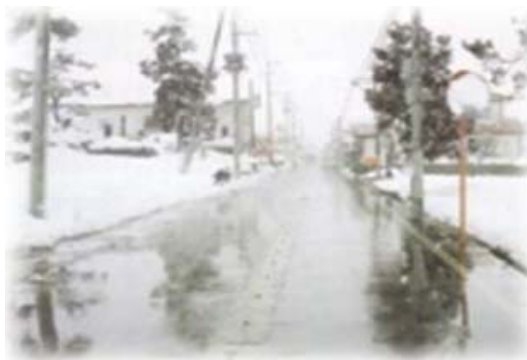
写真：道路散水融雪
