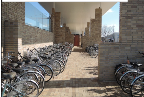
事例① 煉瓦を用いた駐輪場(上州富岡駅)
