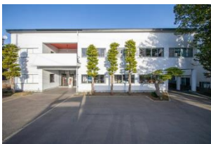
【木村産業研究所 昭和 7 年竣工】
