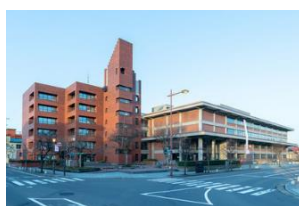
【弘前市庁舎 前川本館 昭和 33 年 前川新館 昭和 47 年竣工】
