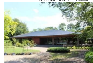
【弘前市緑の相談所 昭和 55 年竣工】
