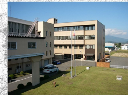
樋の口浄水場
