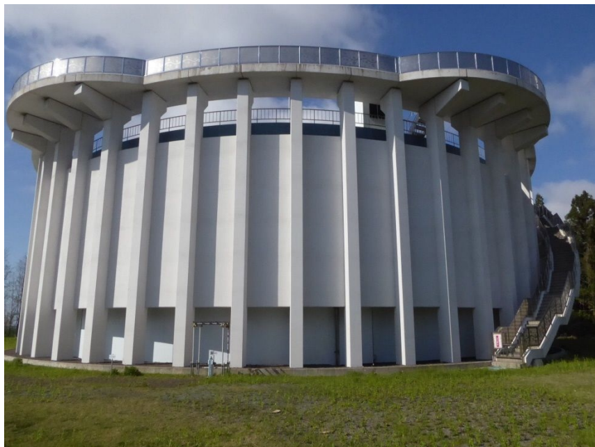
常盤坂配水池
