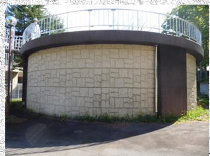
百沢配水場配水池
