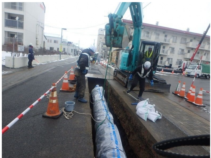
管路布設工事の様子
