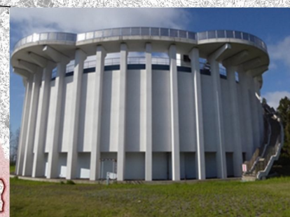
常盤坂配水池
