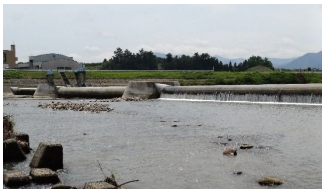
岩木川取水堰（ラバーダム）
