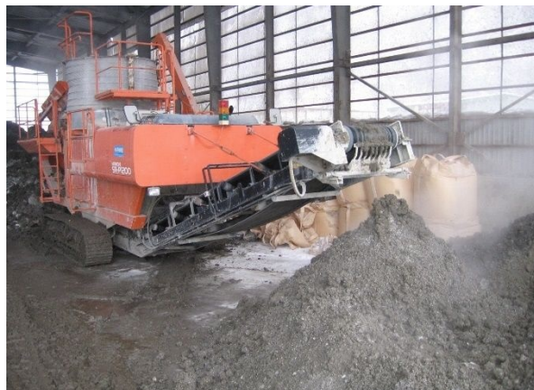
浄水発生土のリサイクル (盛土材料として再利用)
