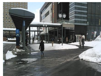
【歩道融雪稼働状況(弘前駅前地区)】
