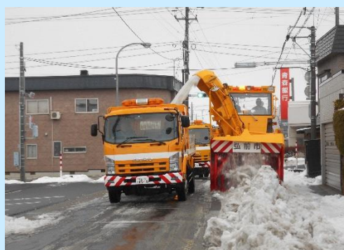
【運搬排雪状況】
