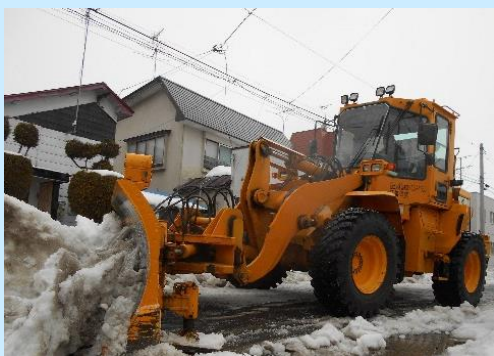
【路面整正状況】
