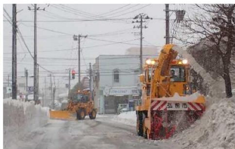
拡幅・路面整正作業の様子
