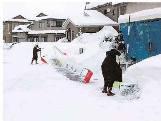
消流雪溝投雪状況
