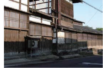
室外機を囲いで覆った例 (加藤味噌醤油醸造元)
