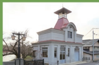
18 旧弘前市消防団西地区団第四分団消防屯所 (紺屋町 2-2 昭和 8 年頃建築) 高さ 14.3 m の火の見櫓がある洋風の外観が洒落た建物。当時の名士の寄付により建築されました。
