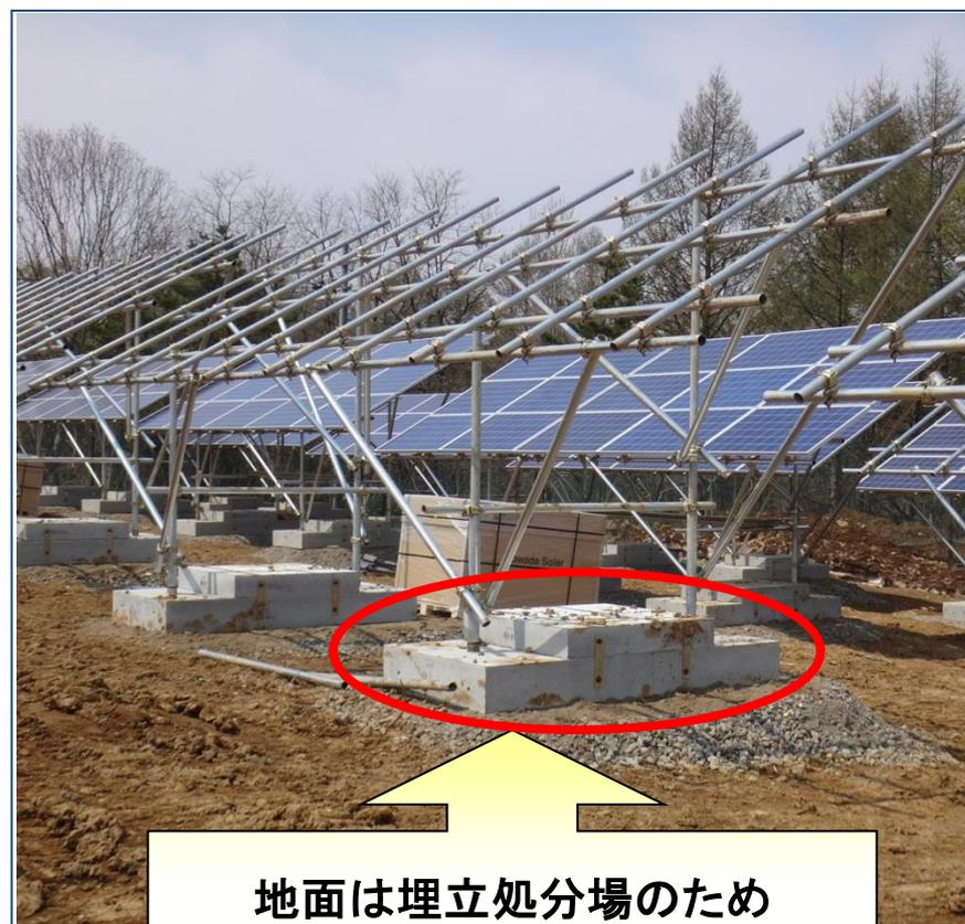
地面は埋立処分場のため掘削することが出来ないのでコンクリート製の置基礎
