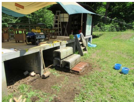
アプローチ広場デッキ階段補修
