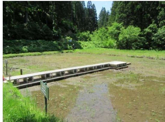
6月1日カナコ菴木道敷設状況
