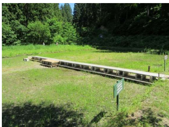
6月17日カナコ菴木道敷板敷設
