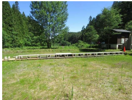
6月17日カナコ菴木道敷板敷設
