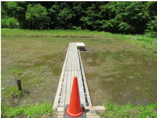
6月1日カナコ菴木道敷設状況
