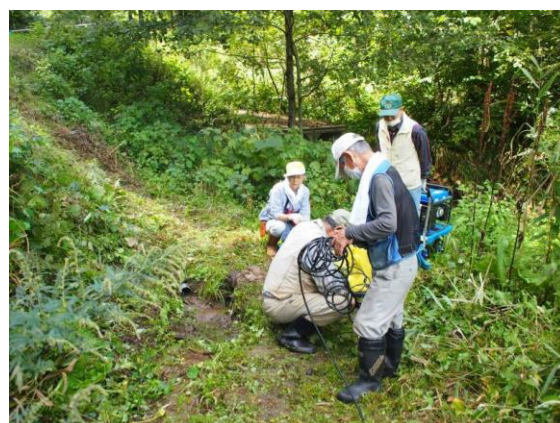
高圧ジェット赤沢取水管閉塞除去
