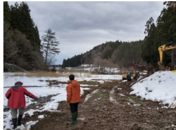
市復旧工事始まる
