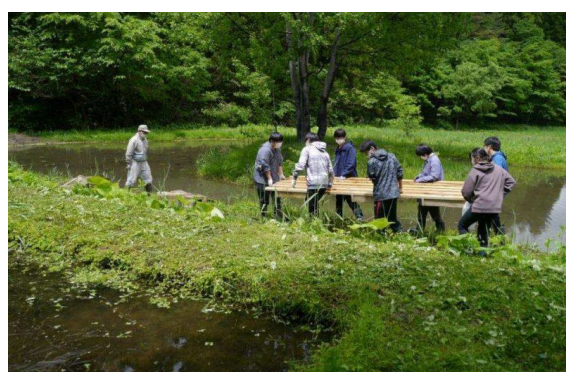
ウルメ池木道基礎板運搬
