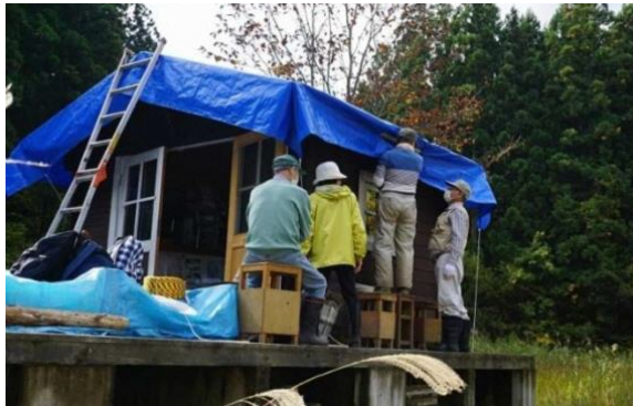
観察小屋屋根ブルーシート掛け
