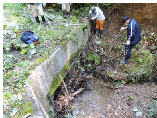
赤沢カナコ菰取水口閉塞除去
