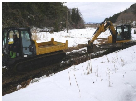
市復旧工事大畑沢土砂上げ
