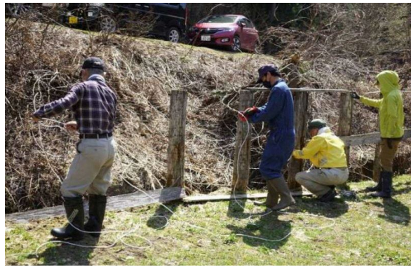
大畑沢防護柵補修
