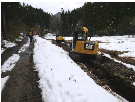
市復旧工事大畑沢土砂上げ
