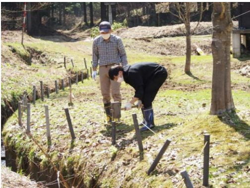
大畑沢防護柵補修
