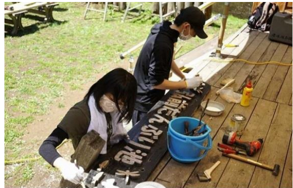
だんぶり池看板塗装補修
