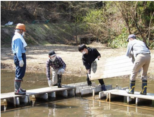
カナコ菴木道歩板敷設
