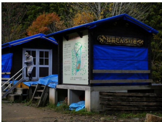
小屋掲示板ブルーシート掛け
