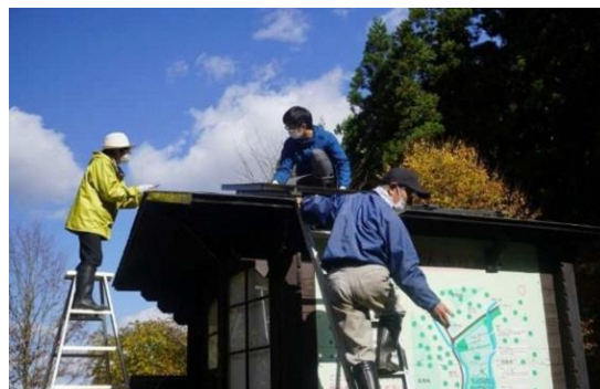
10月10月20日太陽光パネル取り外し
