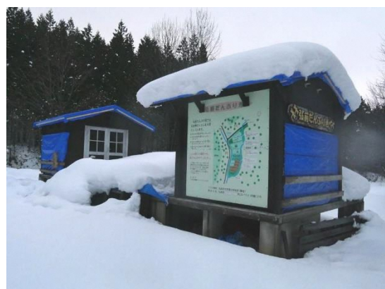
12月26日だんぶり池小屋積雪状況
