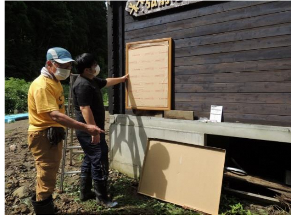
4基目の掲示板設置
