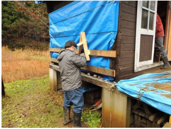
定点カメラ点検
