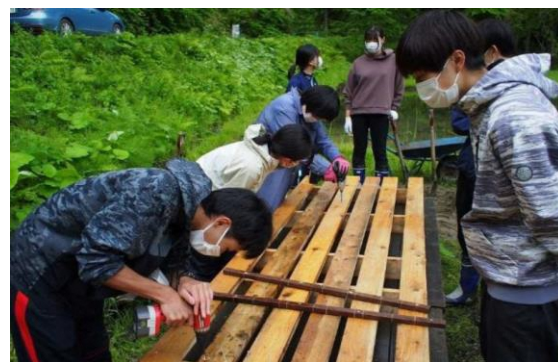
ウルメ池木道基礎板製作
