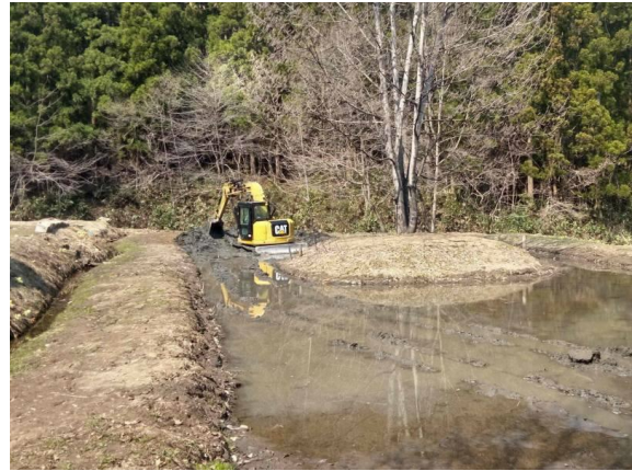
ウルメ池泥上げ修正作業
