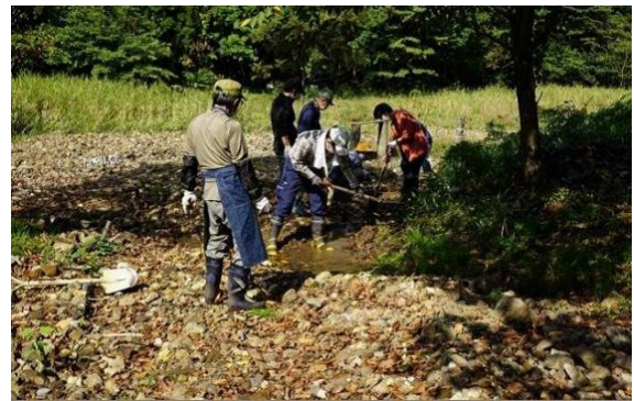
大畑沢水路人力修復
