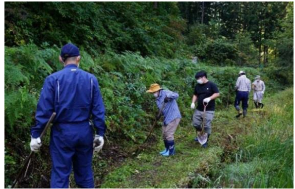
津軽堰水路草刈り・土砂入れ
