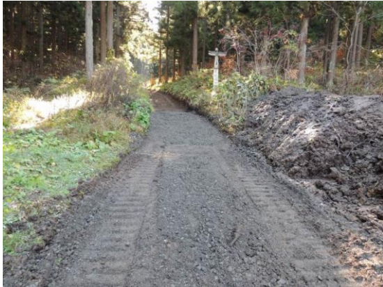
林道復旧状況
