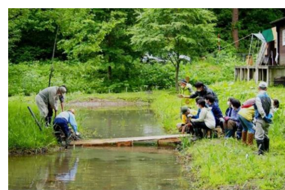
ウルメ池木道基礎板設置
