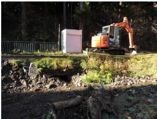
小型重機・倉庫
