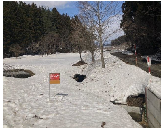
大畑沢水路積雪状況
