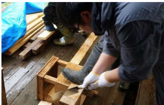
床板材の切り出し
