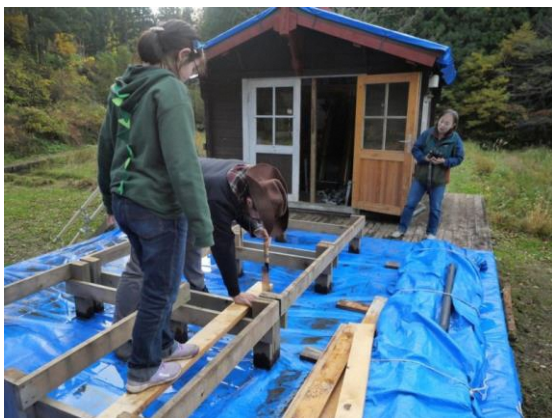
渡橋板材切り出し
