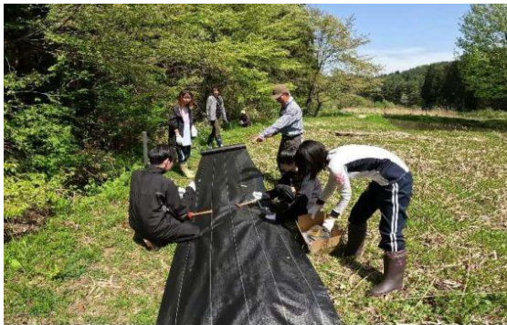
カナコ菰通路部防草シート敷設
