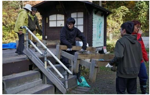
物置台脚部をデッキ上へ片付け
