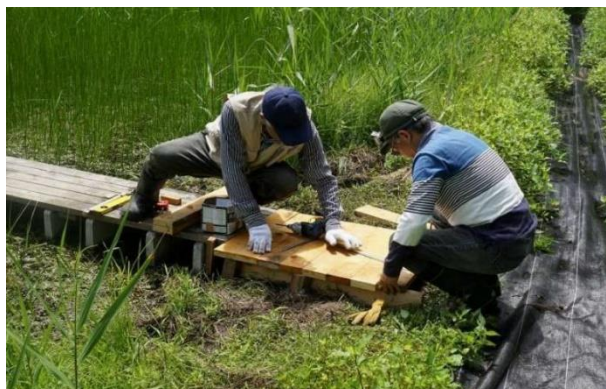
カナコ菰増設木道末端部処理
