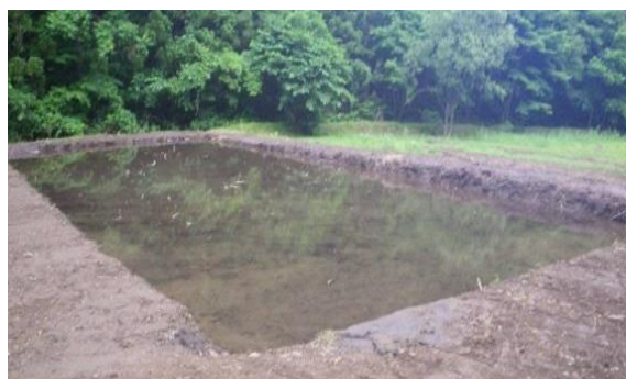
だんぶり島の池浚渫完了
