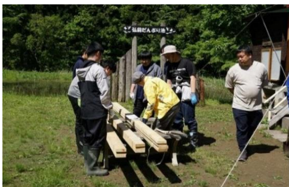
カナコ菰木道敷板製作
