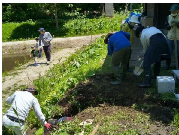
カナコ菰水抜き管設置
