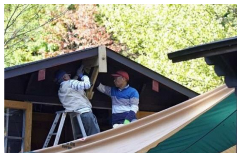
観察小屋正面軒下に雪割板取付け用基台の製作
