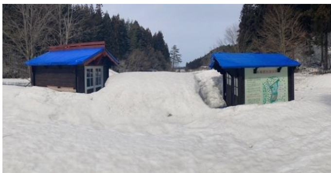
アプローチ広場積雪状況
