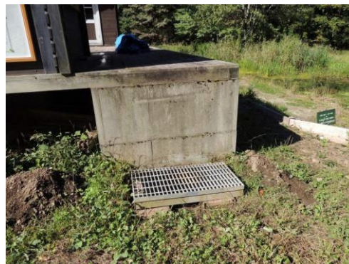
着工前の階段基礎
