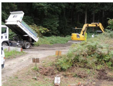
県工事農道整備工事（嶽開発（株））
