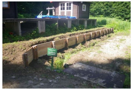
ホタル堰脇板柵設置状況
