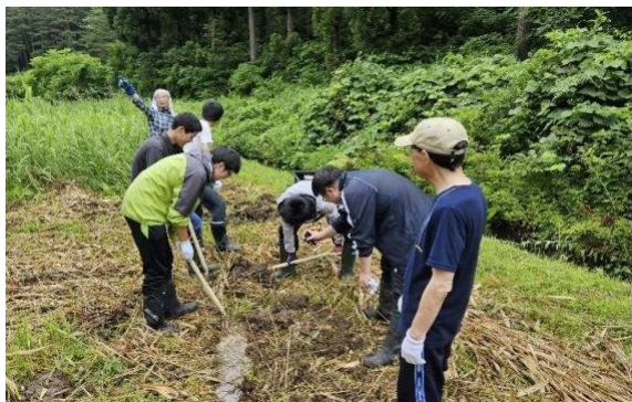
ゲンジ菰導水管敷設掘削作業
