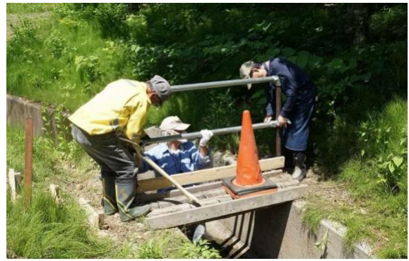
大畑沢渡橋の補修
