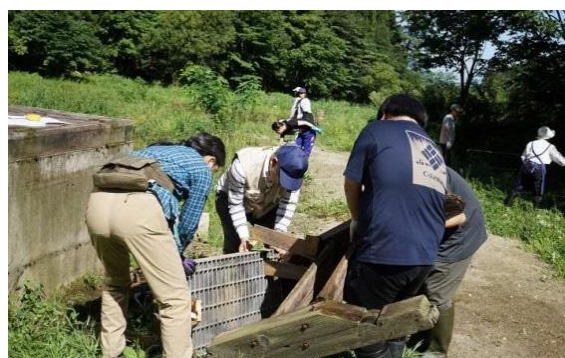
デッキ東側の腐食階段撤去
