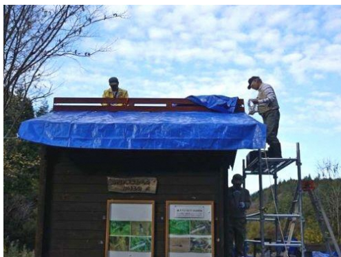
観察小屋屋根ブルーシート掛け
