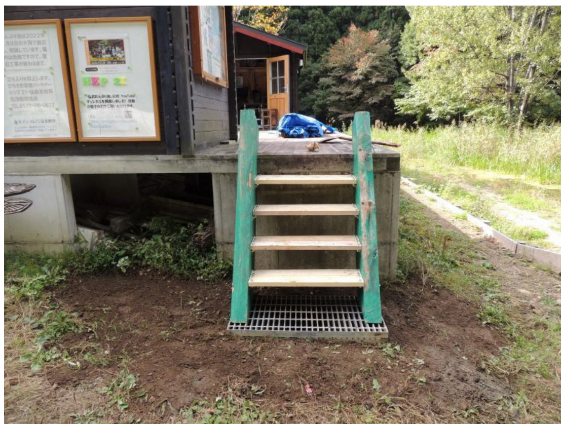
新階段の据付完了
