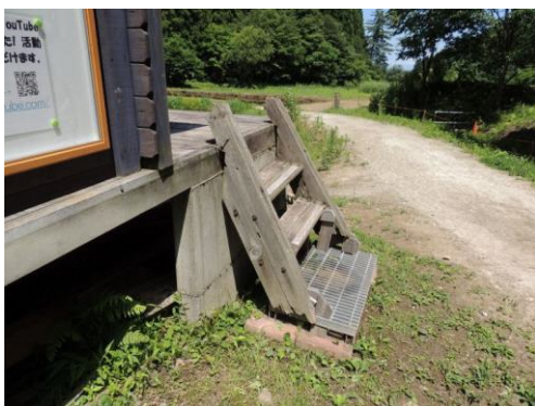
撤去前の旧階段（9月1日）
