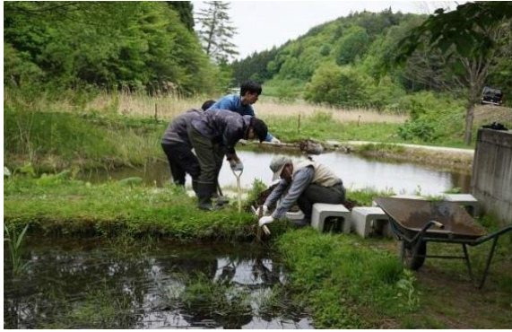
カナコ菰に底水抜き管敷設
