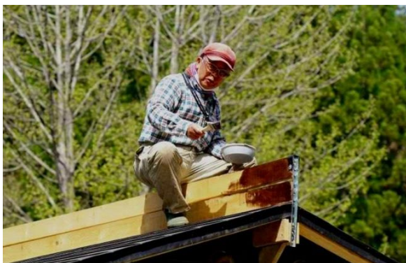
物置小屋屋根雪割板塗装
