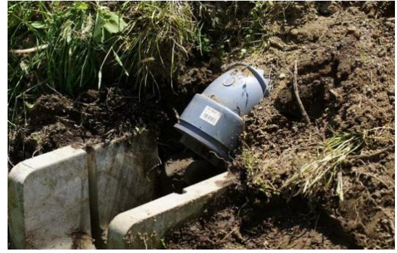
カナコ菰水抜き管完成
