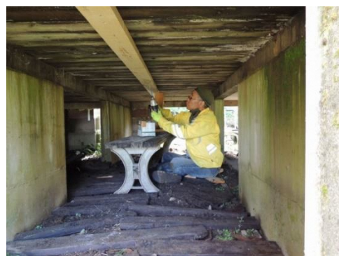
デッキ床板の補強
