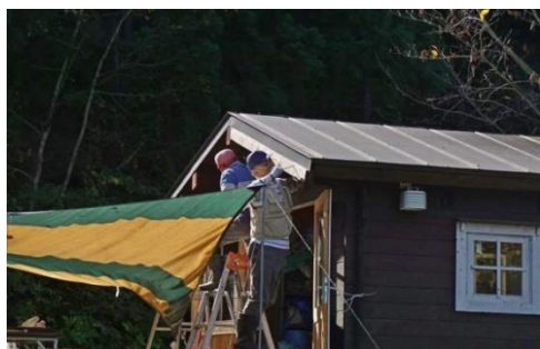
観察小屋正面軒下に雪割板取付け用基台の製作
