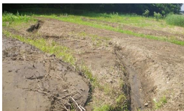
上ヤナギ堰浚渫完了
