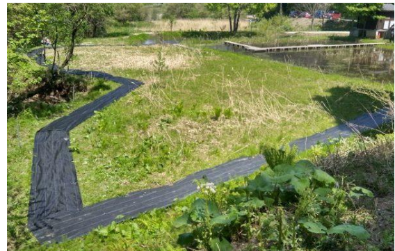
カナコ菰防草シート敷設状況
