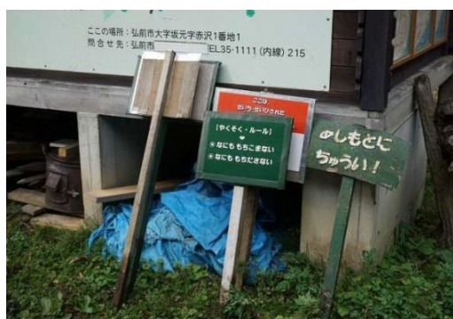
場内立て看板の撤去
