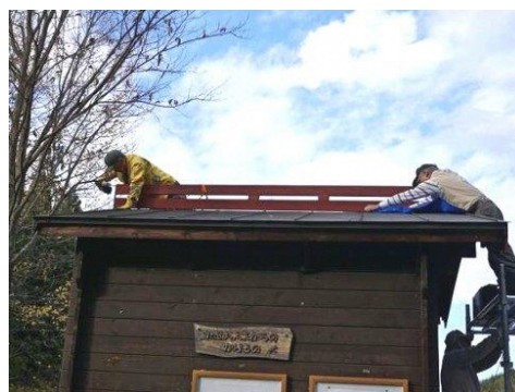
観察小屋屋根ブルーシート掛け
