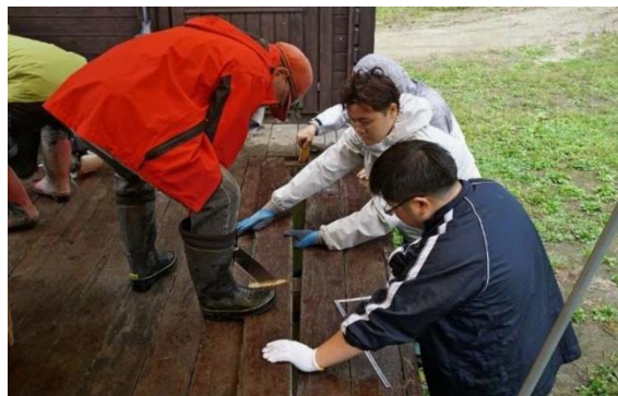
デッキの床板補修
