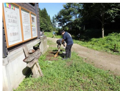
階段の基礎整地作業（9月1日）
