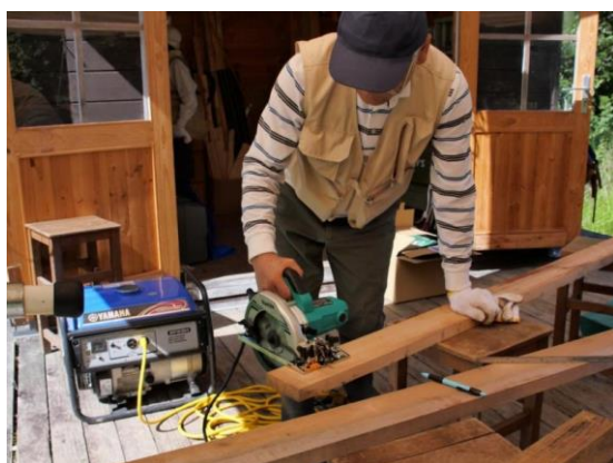
電気鋸による木道補修材の切り出し
