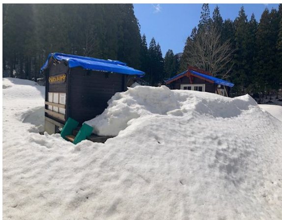
作業小屋落雪状況
