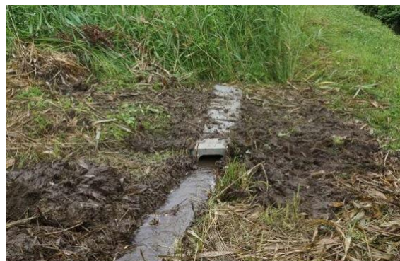
ゲンジ菰導水管完成
