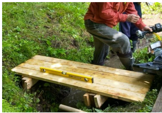
赤沢境界渡橋架け替え完了
