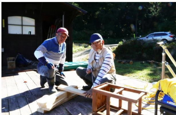
踏板の製作作業
