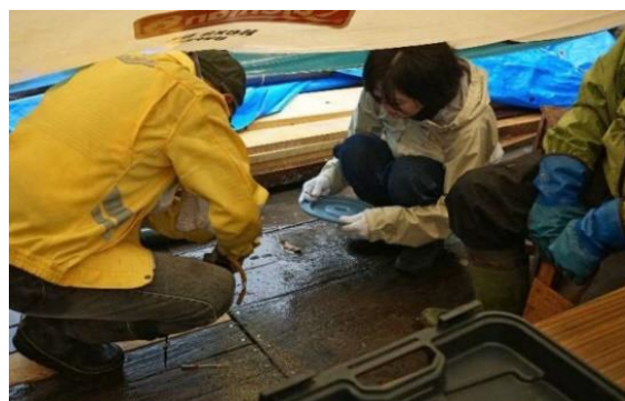
傷んだ床板の取り外し
