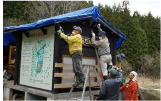
物置小屋ブルーシート取外し
