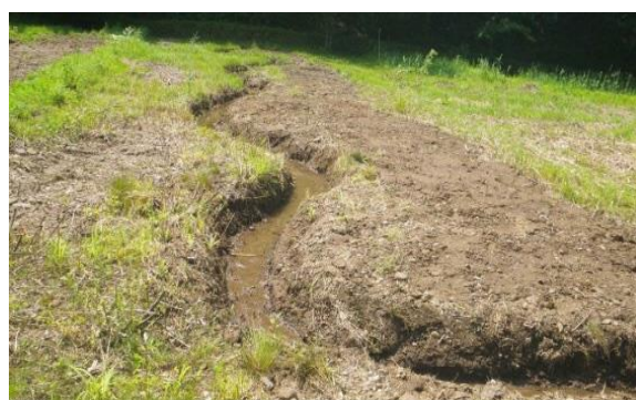
下ヤナギ堰浚渫完了
