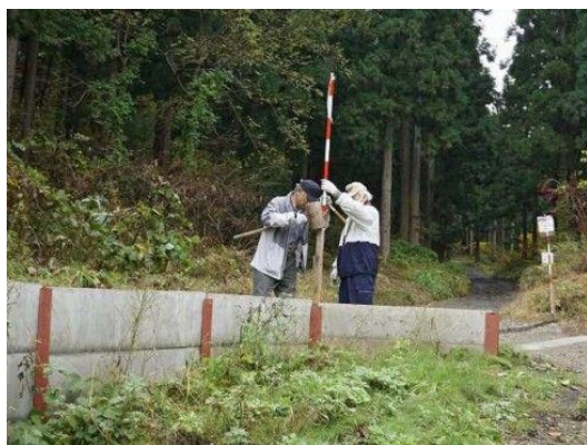
除雪車注意看板取付け
