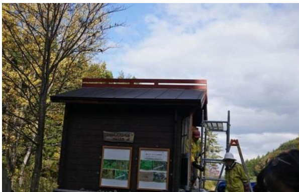
観察小屋屋根雪割板塗装完了
