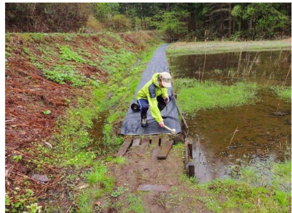
カナコ菰通路防草シート敷設
