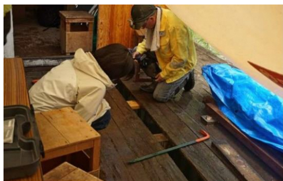
傷んだ床板の取り外し
