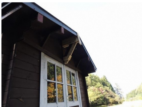
雪割板取付け用正面側軒下基台
