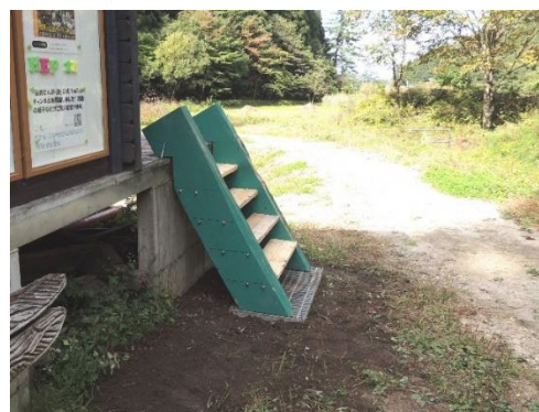
新階段の据付完了
