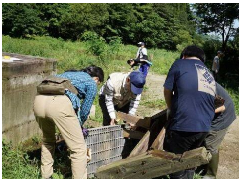
旧階段の撤去作業（9月1日）
