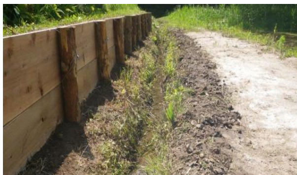
ホタル堰浚渫完了
