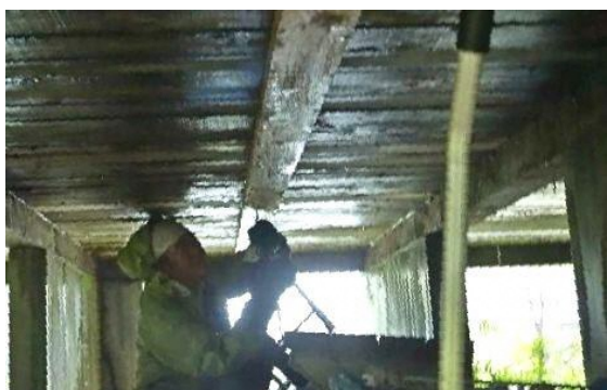
床下からも仮補強
