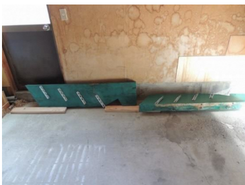
側板にLアングル取付完了（10月12日）
