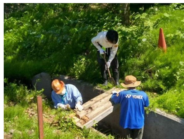
大畑沢渡橋の補修
