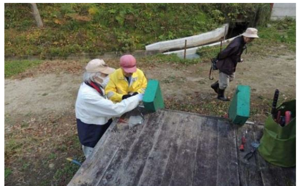
階段固定金具取替え（かすがい取外し）
