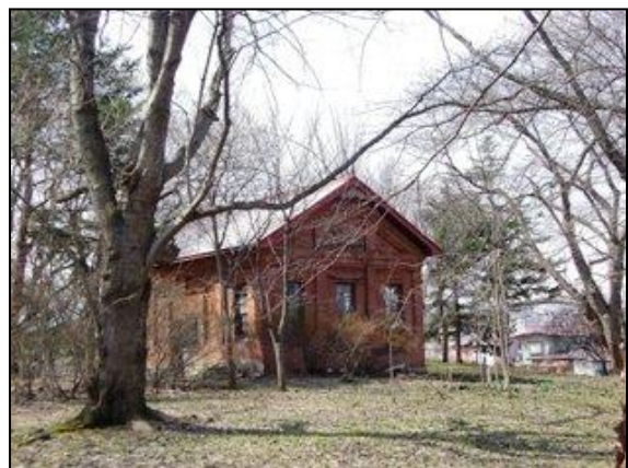
旧福島醸造変電所
