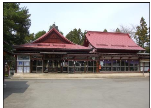
弘前八幡宮（重要文化財）
