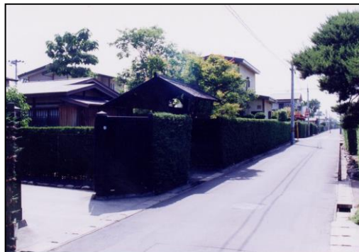
藩政時代の城下町の趣を醸し出す 仲町伝統的建造物群保存地区
