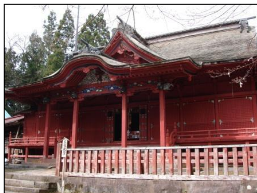
高照神社拝殿（重要文化財）
