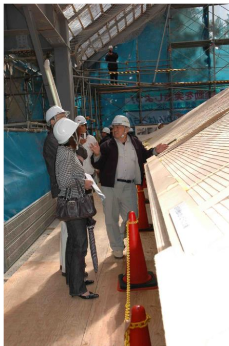
【重要文化財長勝寺本堂修理現場公開】
