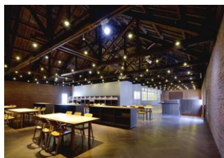
内装工事 2階床フローリング仕上げ
