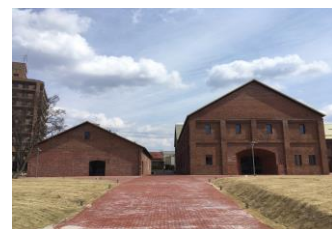
外構工事 ミュージアムロード設置
