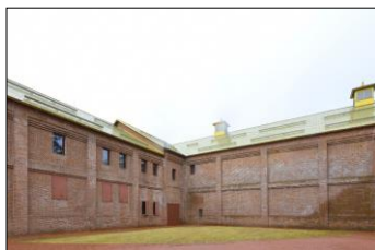
屋根工事(屋根葺き替え) 外装工事(外壁補強他)
