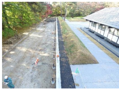
【二の丸南部地区遺構整備工事】
