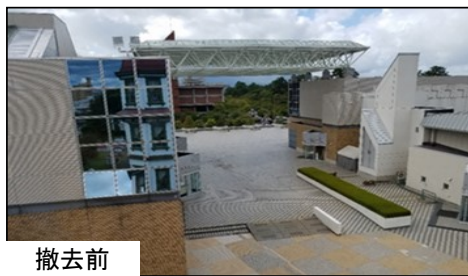
【トラス屋根撤去】
