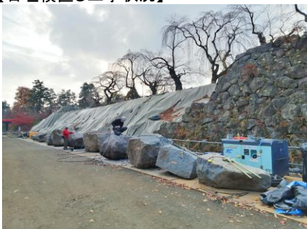
【石垣積直し工事状況】
