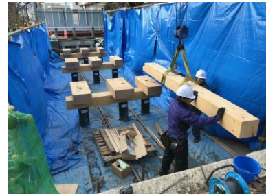
【木橋上部工の架替状況写真】
