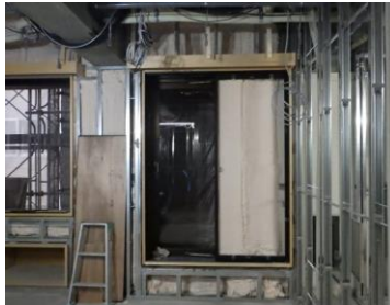
建具2重化及び断熱施工状況
