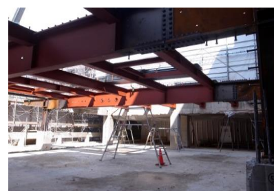
三角屋根部改修 鉄骨造による軽量化
