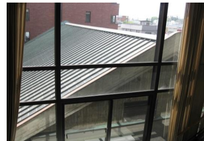
三角屋根部改修前
