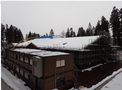
施設建築工事の様子
