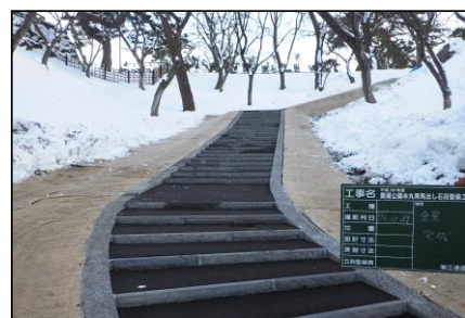
【南馬出し石段整備】
