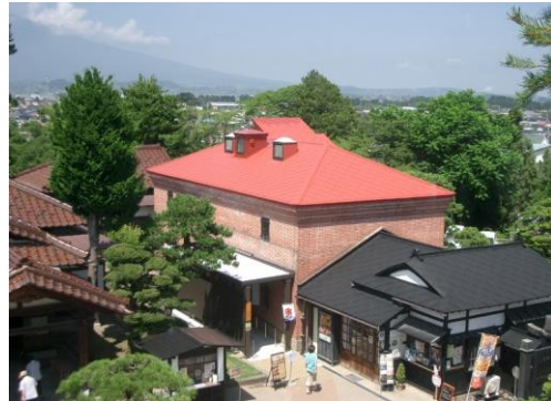
【旧藤田家別邸倉庫(考古館) (※改修後の通称は「匠館」)】
