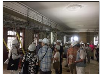
旧弘前偕行社修理現場公開
