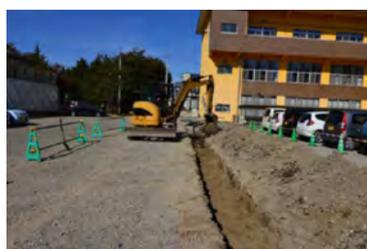
高圧受変電設備に係る電線管の埋設等を行った。
