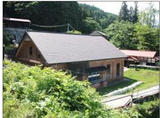
旧福島酒造発電所(吉井酒造発電所)
