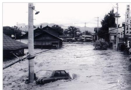
土淵川洪水（昭和50年8月）
