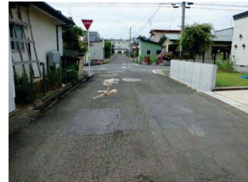
市道城西4号線 城西3丁目(改修前)
