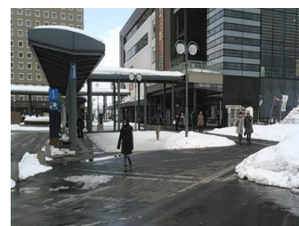
【歩道融雪稼働状況(弘前駅前地区)】
