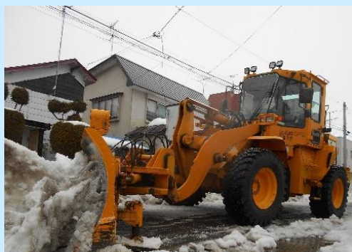
【路面整正状況】
