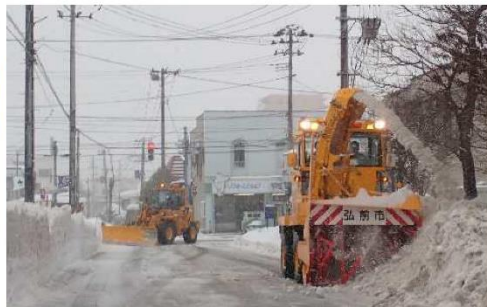
拡幅・路面整正作業の様子
