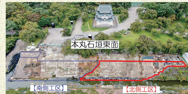
▲石垣積み直し工区の区分け(※2)
