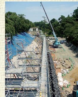
▲積み直しが進む北側工区(令和3年8月)(※1)
