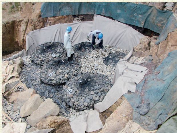
▲井戸跡に栗石を敷き詰める作業（※2）
