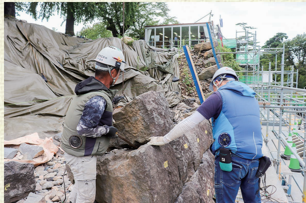
▲勾配を確認しながら、石材の位置・角度を調整する様子（※1）
