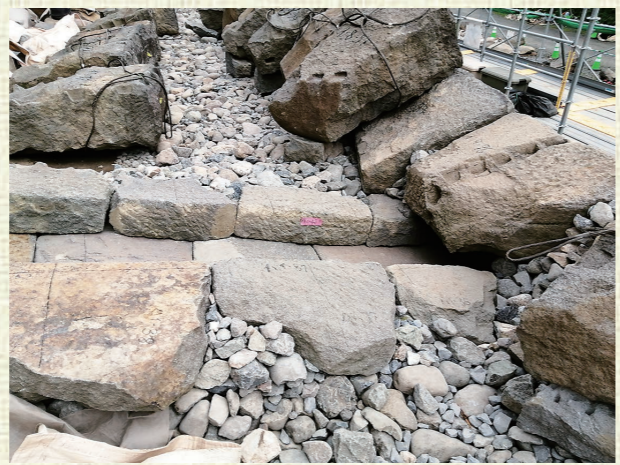
▲本丸の排水を流していた暗渠の復元（※3）
