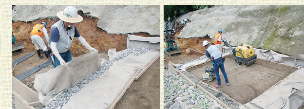
▲湧き水対策設置状況(暗渠〈あんきょ〉排水)(※3)
