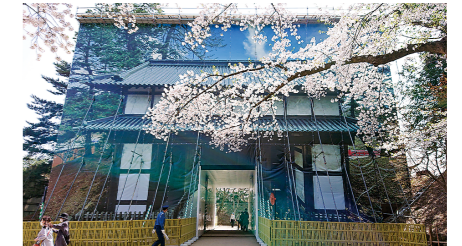
▲工事中の追手門と南内門の外観
