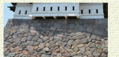
▲(※4) 天守台石垣東面の谷落とし積
