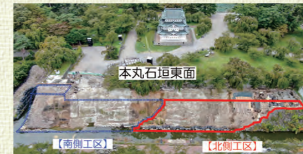
▲(※2) 石垣積直し工事の工区分け
