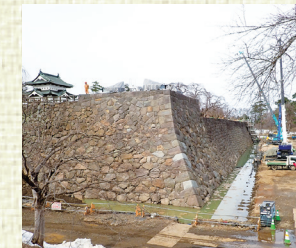
▲（※1）石垣積み直し終了後
