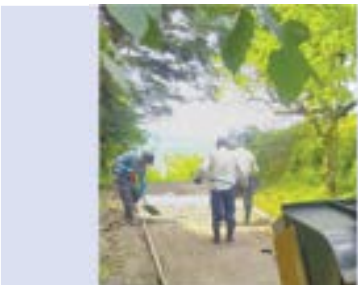
舗装作業の様子
